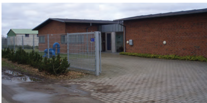
Vamdrup vandværk set fra vejen med en af de gamle rentvandspumper som blikfang.
