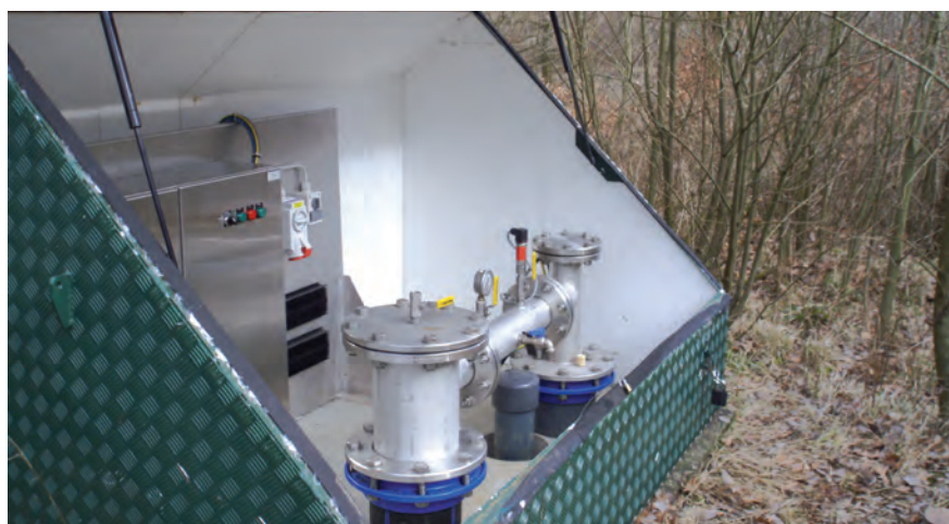
På den nye kildeplads er der 3 borer, som alle er forsynet med overjordisk råvandsstation. Boringernes dybde er mellem 80 og 100 m., og hver boring giver godt 60 m 3 /time
